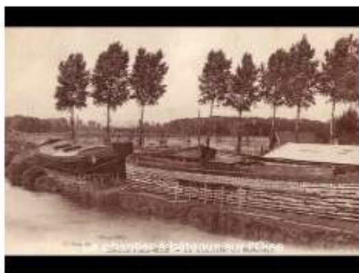
Le chantier naval de Choisy-au-bac
