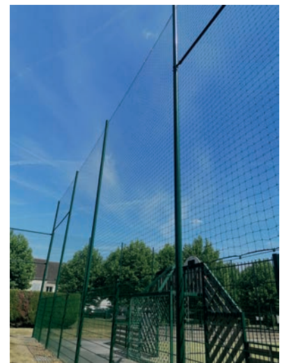
Pose des filets pare ballon au city stade
