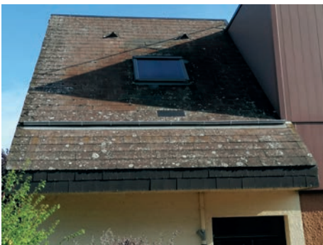
Changement gouttière - gymnase
