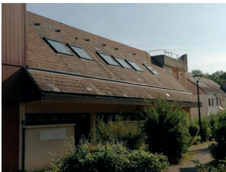
Changement gouttière - gymnase
